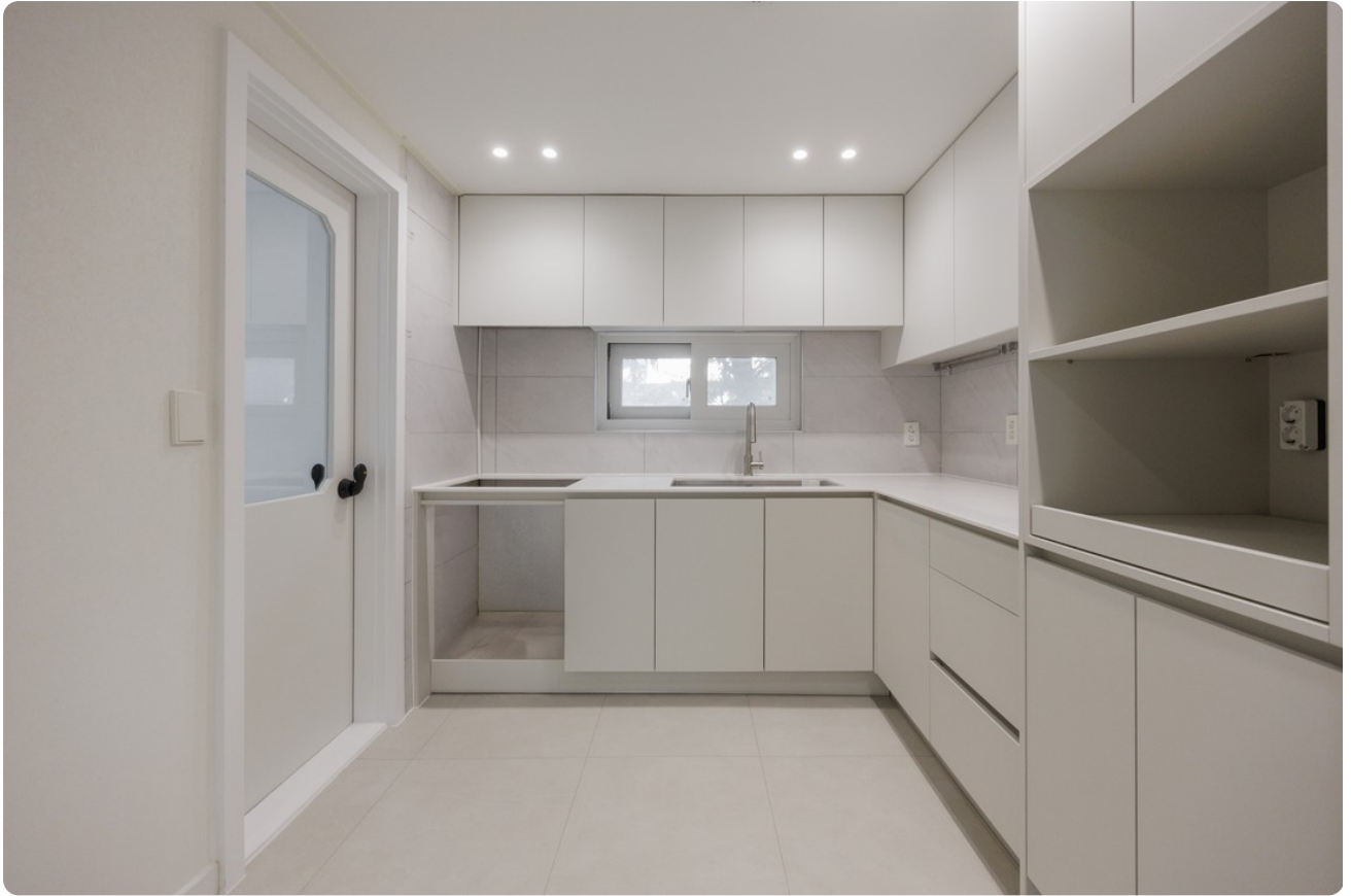
무아 시공 사례 · 엑스포 5단지
