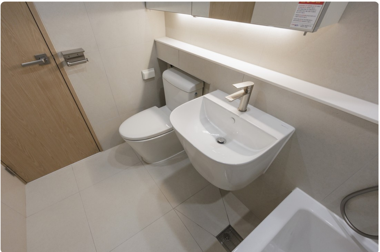
무아 시공 사례 · 엑스포 2단지
