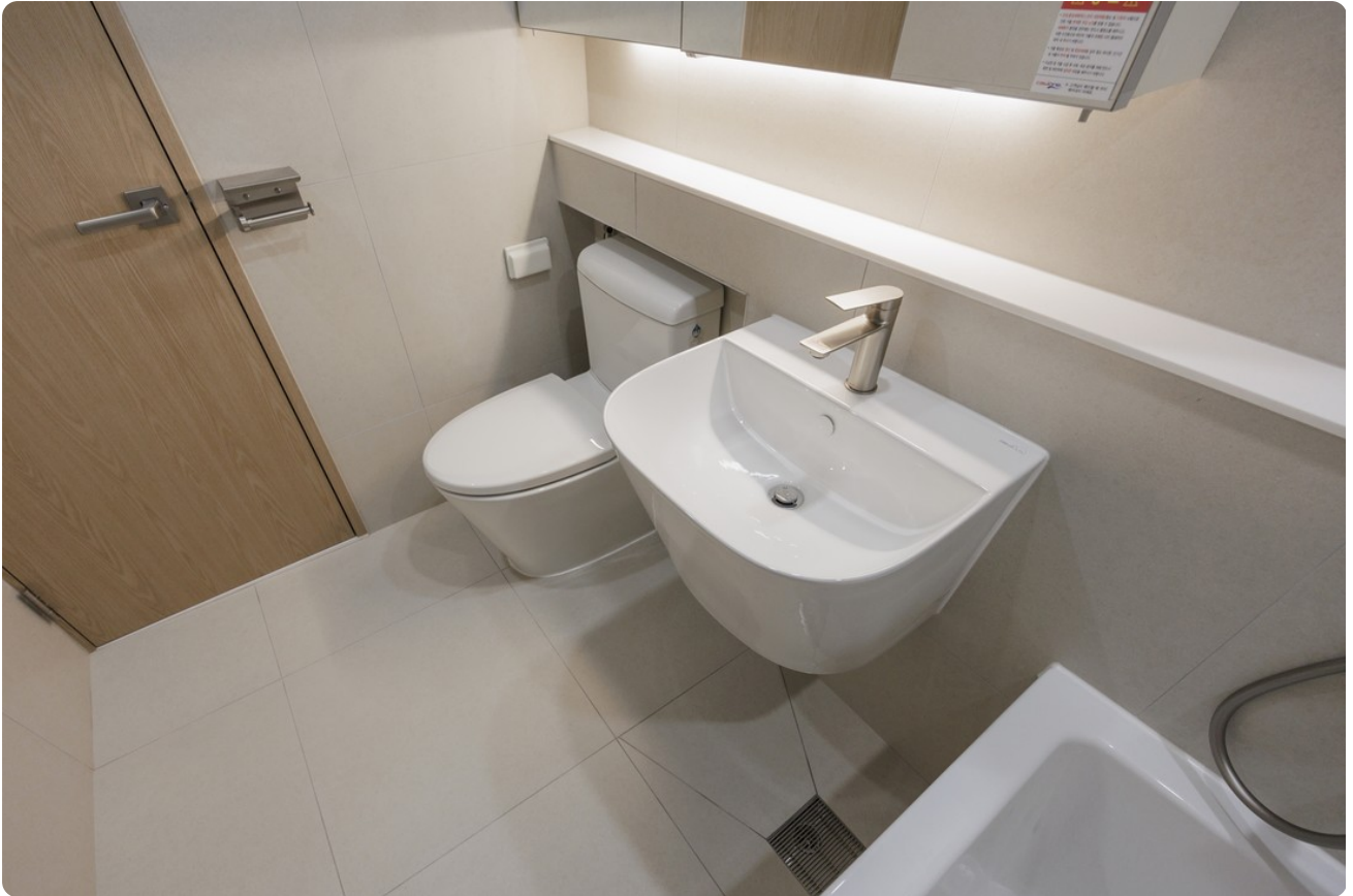
무아 시공 사례 · 엑스포 2단지
